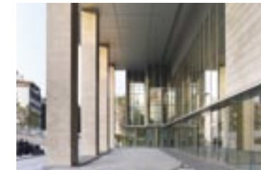
広場空間は、上野と御徒町を結ぶ歩道から連なっており、開放性、利便性、安全性を備えています。
